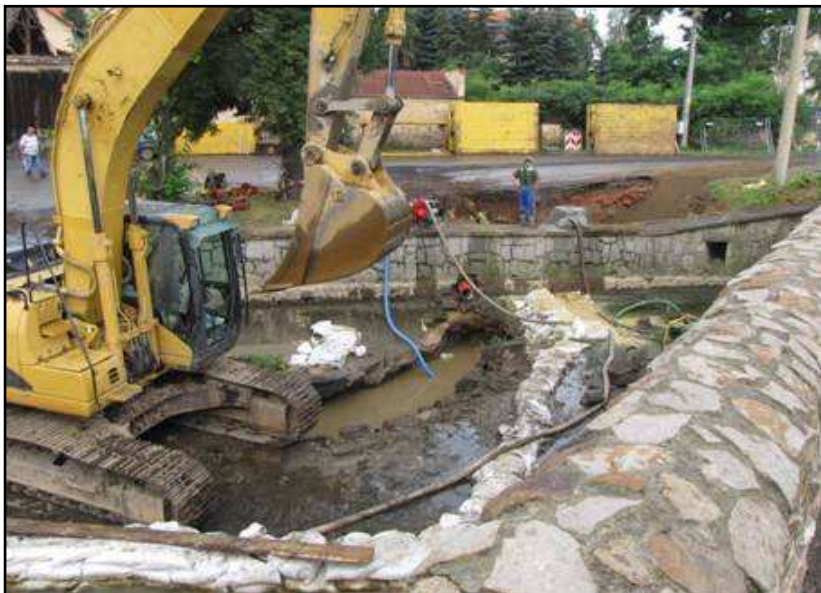
Želénky - stoka K2, podchod potoka Bouřlivce
