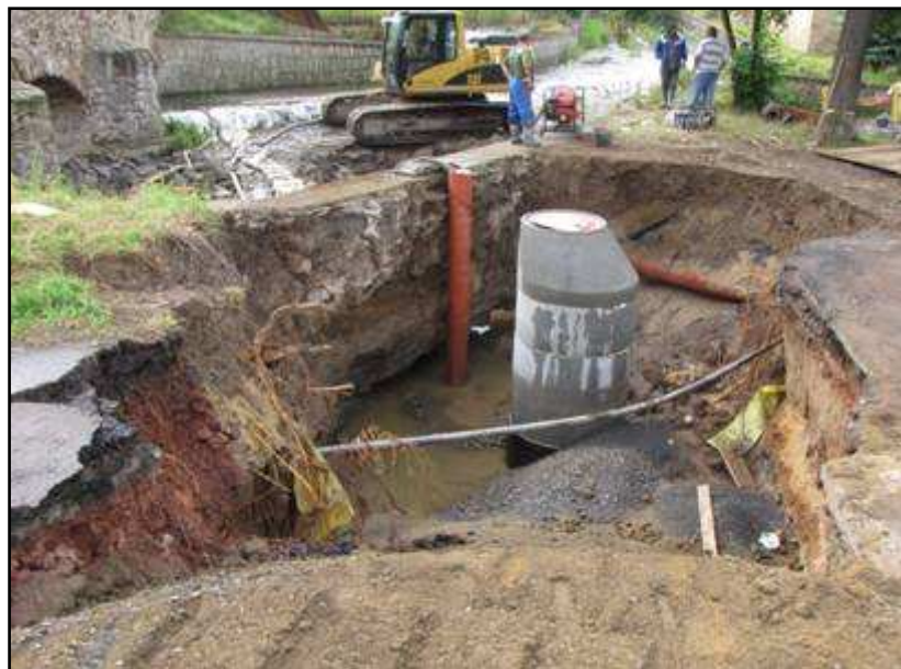
Želénky - stoka K2, podchod potoka Bouřlivce
