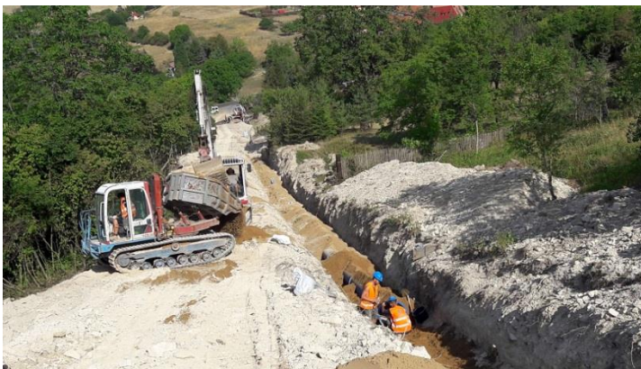
Rekonstrukce přiváděče pro Ústí nad Labem u Michalovic
