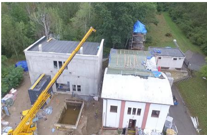
Rekonstrukce ÚV Holedeč
