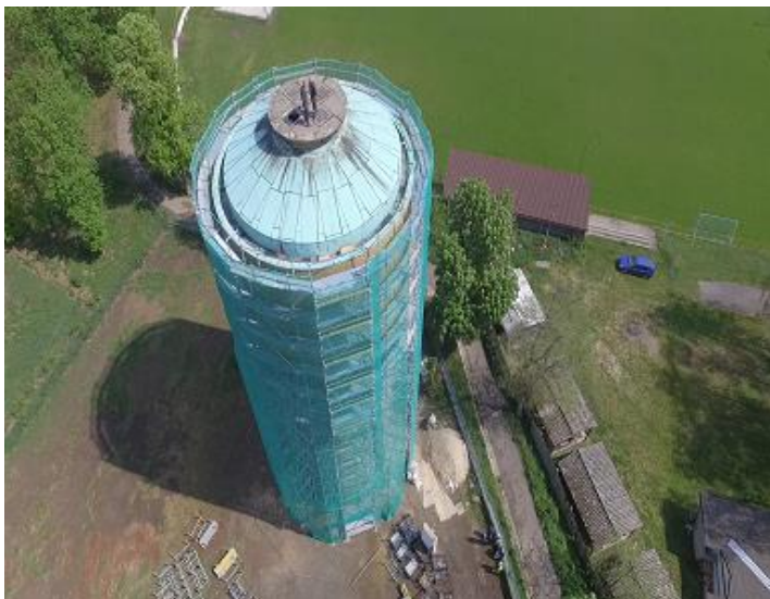
Komplexní rekonstrukce vodojemu v Terezině
