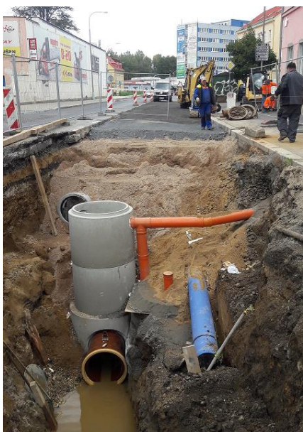
Rekonstrukce vodovodu a kanalizace v Liberci, ulice Dr. M. Horákové
