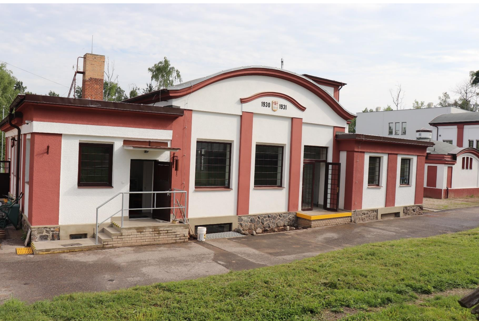
Rekonstruovaná ÚV Holedeč
